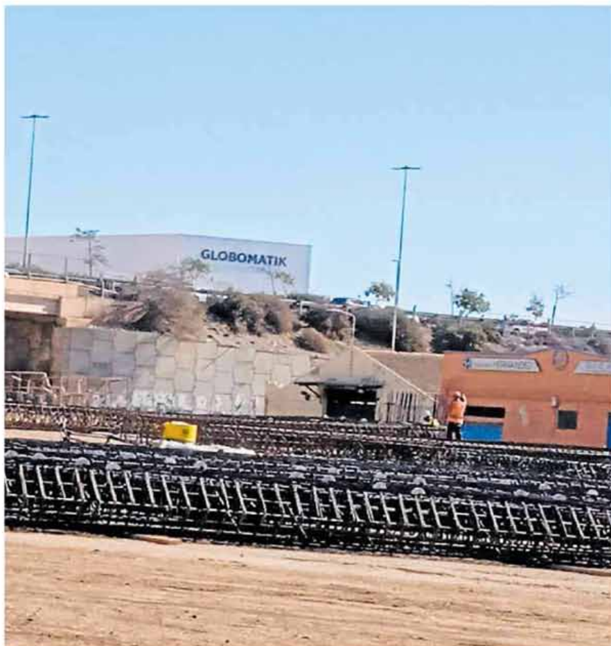
◀ Paso elevado. Una de las siguientes estructuras viales en caer será el puente de la autovía del Aeropuerto, y también está en estudio el túnel de La Goleta.
