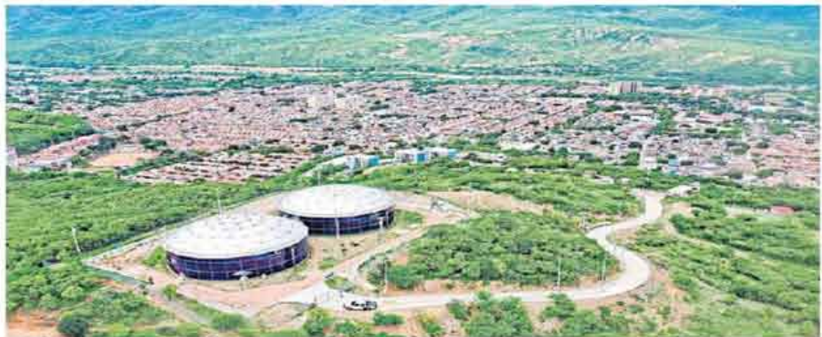
Las obras se ejecutaron en cuatro municipios con una extensión de 25 kilómetros. En la foto los tanques de almacenamiento de agua en el sector de La Cumbre, en Los Patios. / Foto: Carlos...
