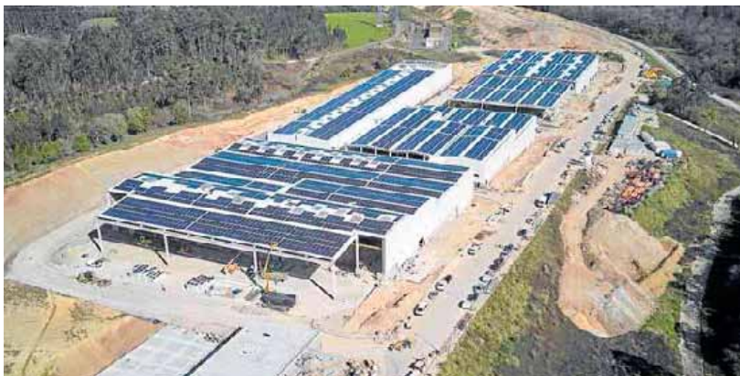
La planta de basura bruta, durante las últimas fases de su construcción. COGERSA
